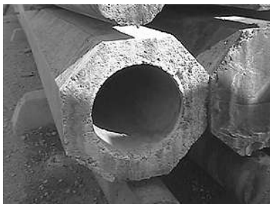
Figura 29. Poste de Concreto Octogonal
